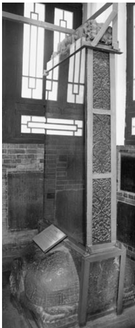
図7 碑石倒壊防止鉄枠
