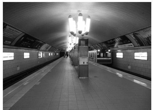
写真3 高いアーチ状天井の御堂筋線淀屋橋駅
