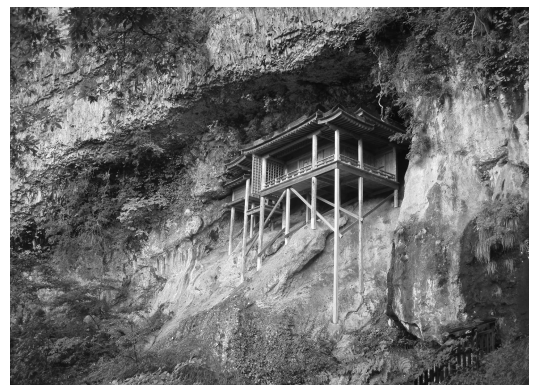
写真2 断崖の岩窟に建つ三佛寺投入堂
