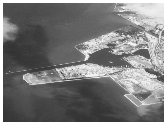
写真2 閘門式のドッグを備えた三池港
