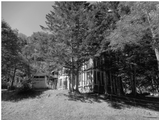
写真9 幌内炭鉱景観公園の幌内炭鉱変電所
