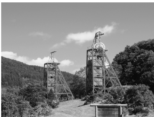
写真10 三菱美唄炭鉱立坑槽
