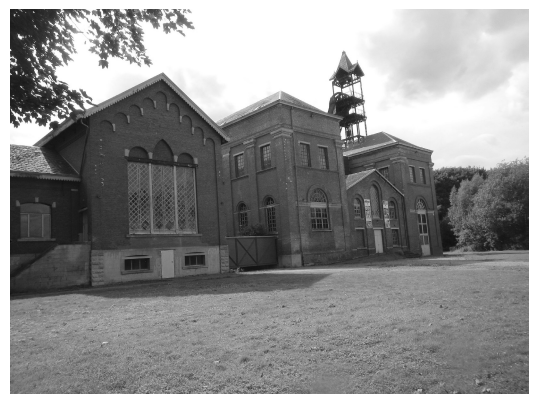
図1. 炭坑へ入る建物(中が資料館)
